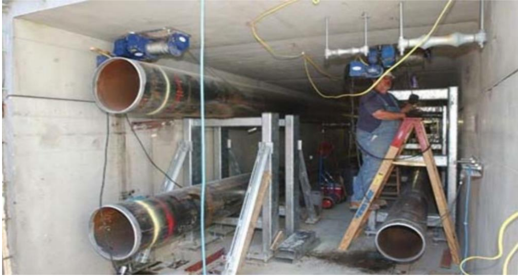
Şekil 3 - United States Capitol Visitor Center Utility Tunnel iç görünüş (Capitol Visitor Center Project Office, 2005).
